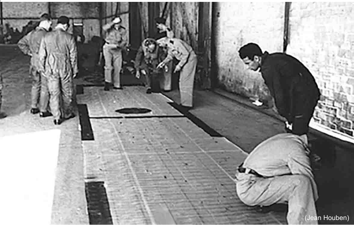
La Sénia, 1956 – Comptage des impacts après un tir air-air des Mistral du GC 1/6
