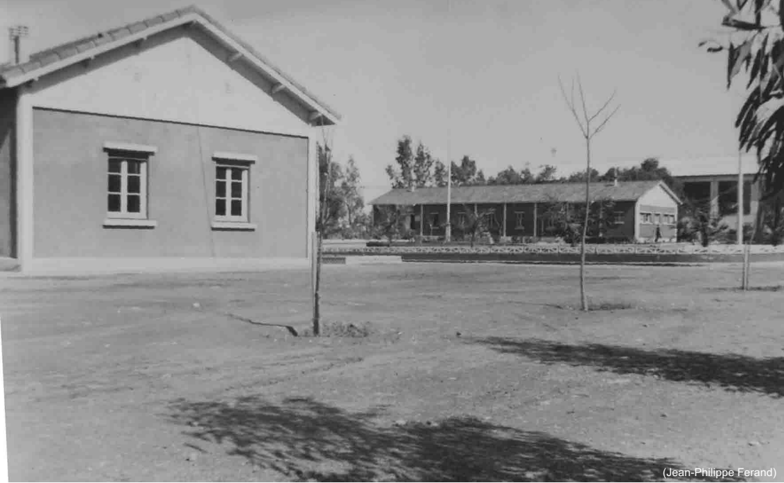
Les installations de la CLA 2 sur la base de Blida
