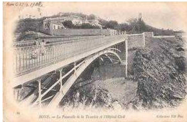
Le Pont de la tranchée. La tranchée en dessous a été creusée en 1875 pour permettre aux remblais extraits de la carrière des Santons d'arriver plus facilement à la Grande Darse.
