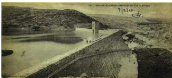
Photo du Barrage après les travaux de 1910.
