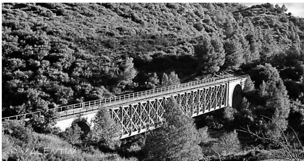
Pont de MOUZAÏA-LES-MINES
