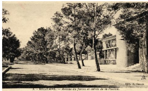
L'avenue du Fortin à RELIZANE
