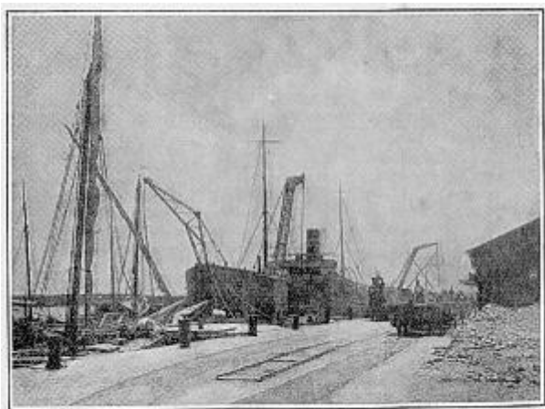
Fig. 28. — L'EMBARQUEMENT DES PHOSPHATES AU PORT DE BONE Terminus de la ligne ferrée Bône-Tébessa, ce port exporte annuellement 700.000 tonnes de phosphates et 800.000 tonnes de minéral de fer.
