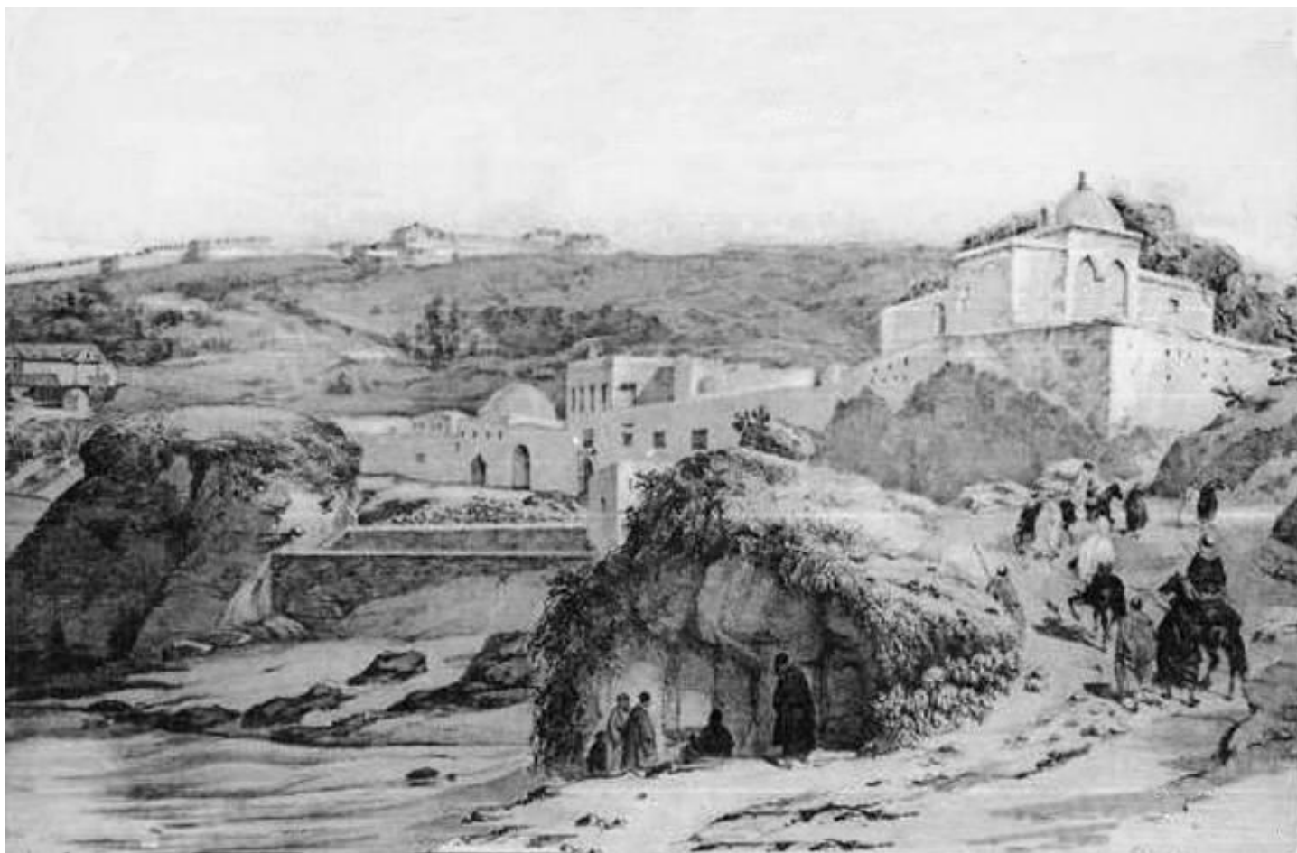
DAR EL BAROUD : Marabout et Salpêtrière du Dey en 1837. Caserne Salpêtrière (Faubourg de Bab-El-Oued)
